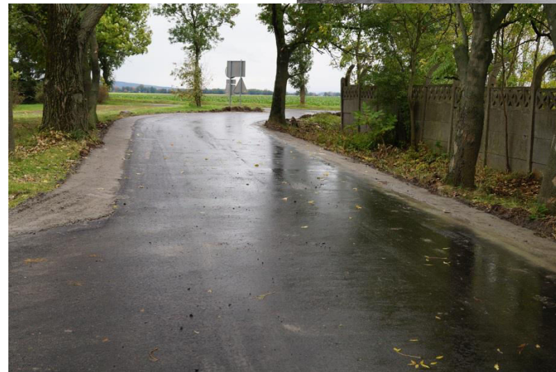
Po zakończeniu realizacji inwestycji
