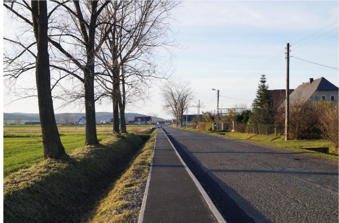
Po zakończeniu realizacji inwestycji
