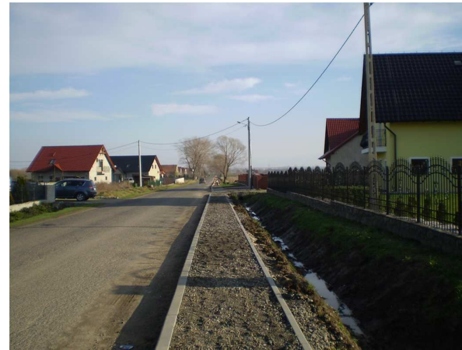
Chodnik w trakcie realizacji.
